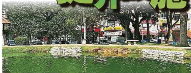
湖边严重崩塌，已使用沙包稳固，日后再用大石头围住。
