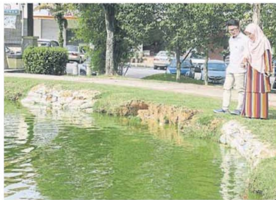
■公园中的湖畔湖堤已崩坏需要维修，左起是丘钦瀚及颜丽丽。
