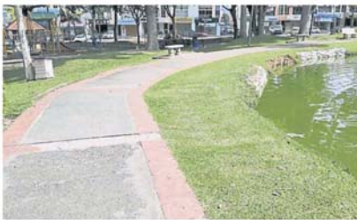
休闲湖破烂的走道和崩塌的湖畔将重修。
