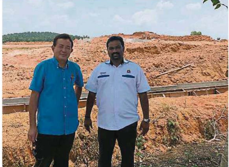
西华古玛(右)与雪邦村长戴祖兴巡视雪邦综合墓园工地以了解工程进展。
